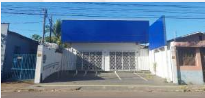
Fachada do Cepem. Fonte: Acervo próprio (jun. 2024).
